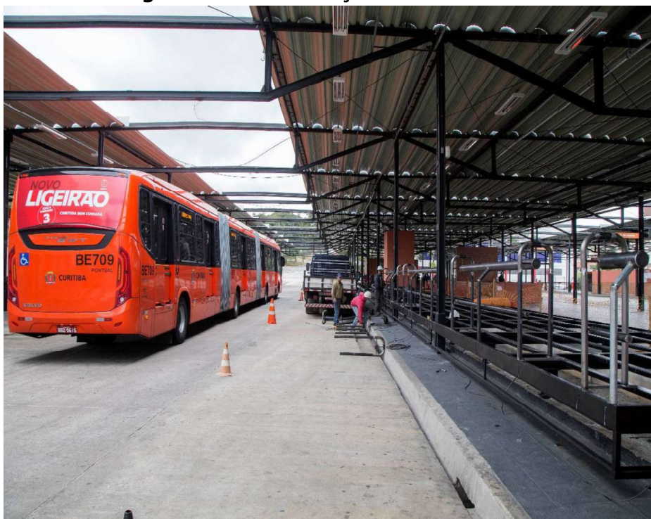
Imagem 14: MANUTENÇÃO DOS TERMINAIS
